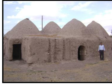
Foto 8. Kümbet Evlerin Batısında Ayrı Girişi Olan Misafir Odası (Yatırtepe Köyü).
