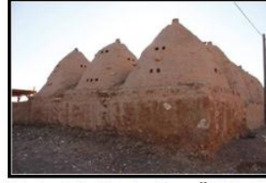
Foto 28. Taşlardan Örülmüş, Kare Planlı Odalardan Oluşan Harran Evlerinin Dış Görünüşü.
