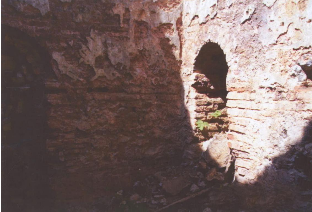
Resim 6: Ilıklıkta doğu duvarındaki yan giriş
