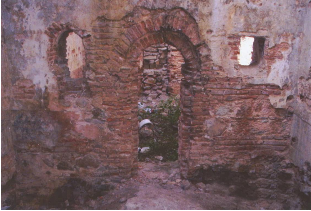
Resim 9: Sıcaklıkta kuzey duvarındaki geçiş açıklığı
