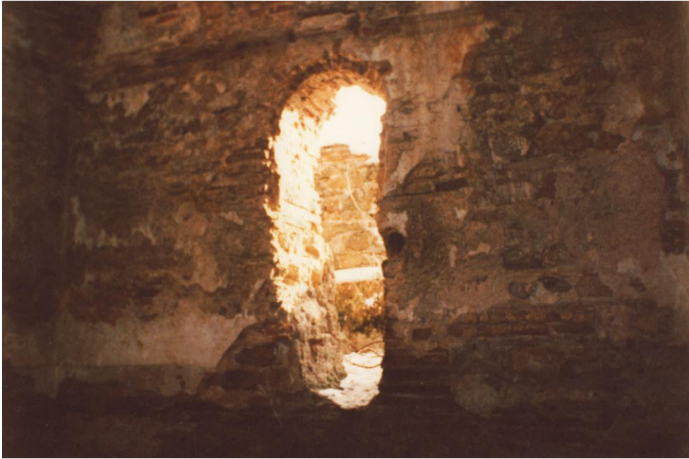
Resim 10: Sıcaklıkta güney duvarındaki pencere nitelikli açıklık
