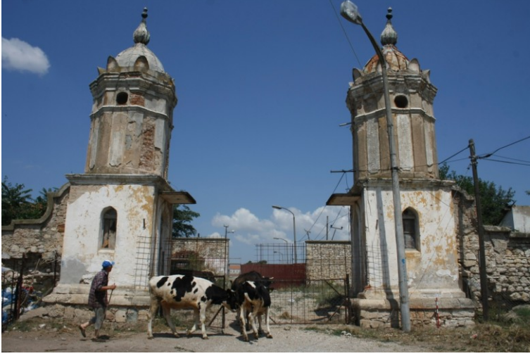
EYSK, Süvari Kışlası, güney avlu giriş kulelerinin görünüşü
