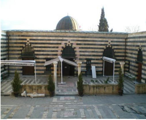
Foto. 29 Gaziantep Boyacı Camii Avlu Döşemesi.
