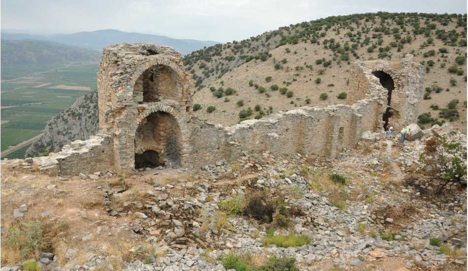
Resim 20 - İç kale güney beden duvarı ve kuleler.
