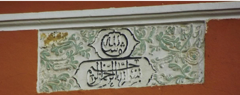
Fot. 10 - Ödemiş Ulu Cami, batı cephenin güneydoğu köşesindeki kitabe.
