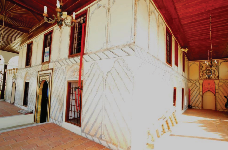
Resim 2 - Cincin Köyü Cihanoğlu Abdülaziz Efendi Camii, dış cephe süslemesinden genel görünüm.
