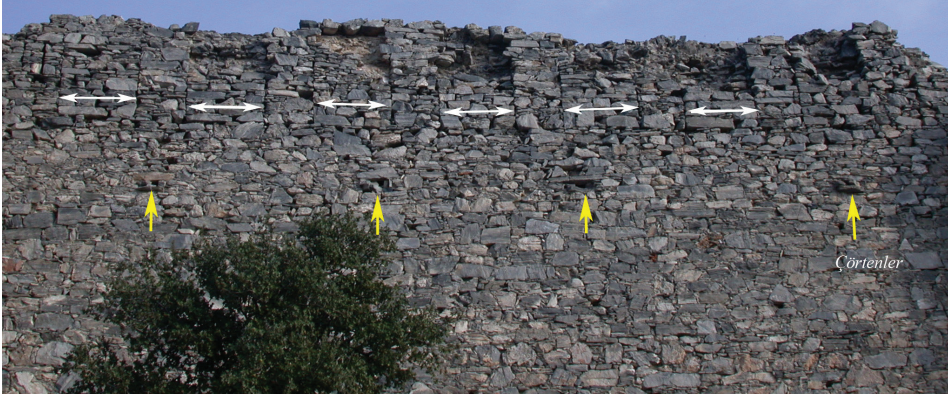
Resim 14 - Batı cephe duvarında takip edilen dönem izleri. İlk evre mazgal siperlerinin arası kapatılıp sur yükseltilmiştir. İlk evre seyirdim hizasında olan çörtenerler daha sonra cephenin alt kesiminde kalmıştır. (E. Tok arşivi, 2004.)
