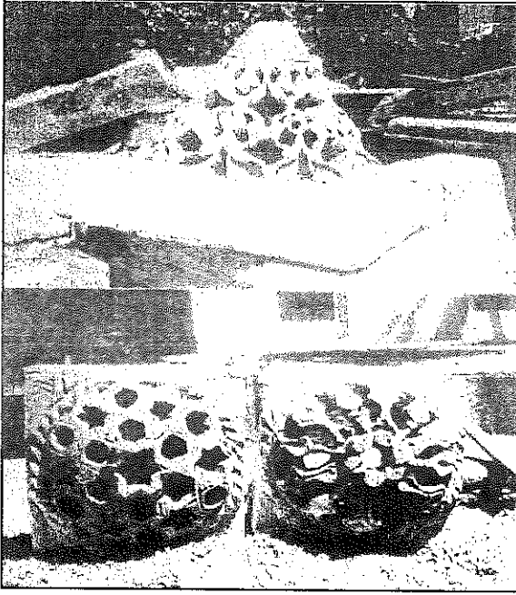
Resim 12 - Câmiinin yıkımında muhafaza edilerek yeniden eski yerlerine konan parçaları
