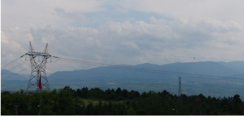
Şekil 2. 380kV Pheasant hattı görünümü (View of 380kV Pheasant line)
