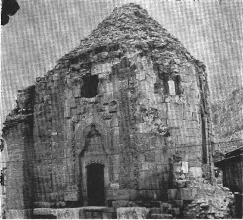
4. Resim — Amasya, Halifet Gâzi Türbesi onarımdan önceki durumu.
