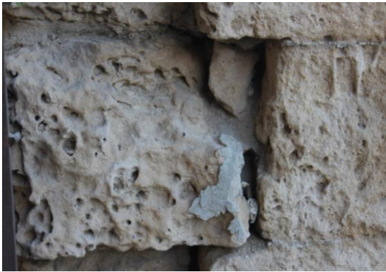
Şekil 7. Gazimağusa Kaleiçi St. Nikolas Katedrali giriş cephesinin iç kısmının yapı taşlarında görülen oyuklanmalar
