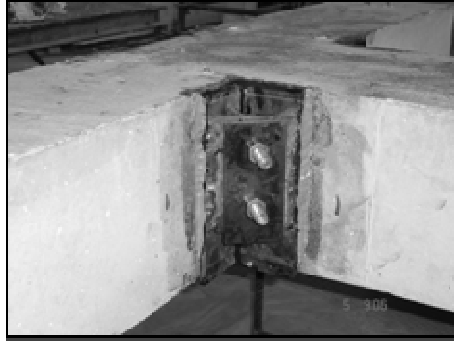
Şekil 5. Çelik donatı uçlarının somunla tutturulması
