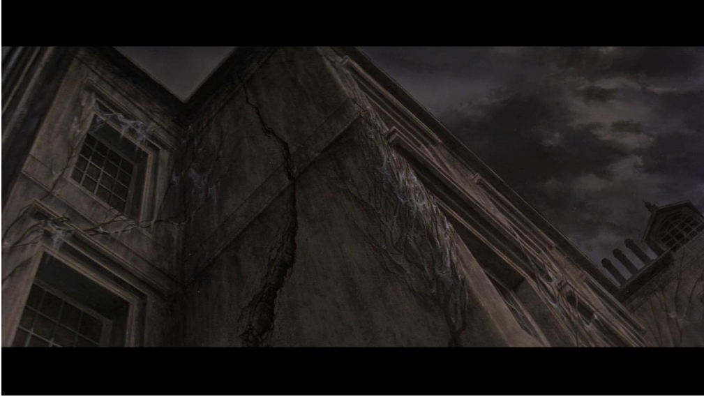
Resim 2: Malikânedeki devasa çatlak Usherların yok oluşuna da işaret etmekte.
