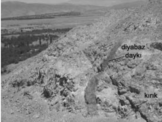
Şekil 3. Baraj yerindeki diyabazlardan bir görünüm. Figure 3. A view from diabases at the dam site.
