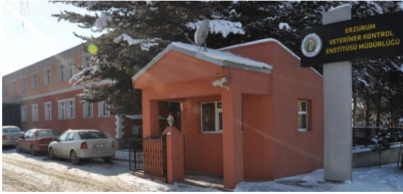
Şekil 2. EVKEM Dış Cepleden Görünüm. Figure 2. Outside View of EVKEM.
