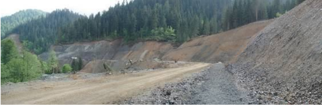
Şekil 1. Nehir tipi HES yapımı sırasında peyzaj onarımı gerektiren alanlar.
