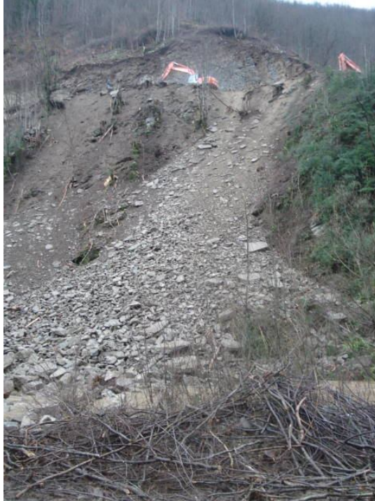
Şekil 4. HES projesi kapsamında çıkan toprağın yan şevlere bırakılması
