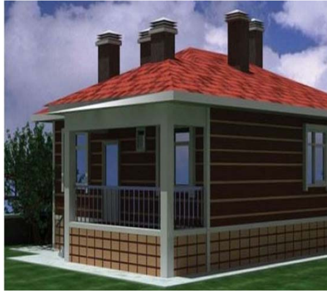
Şekil 19. Doğru baca uygulama örneği.
