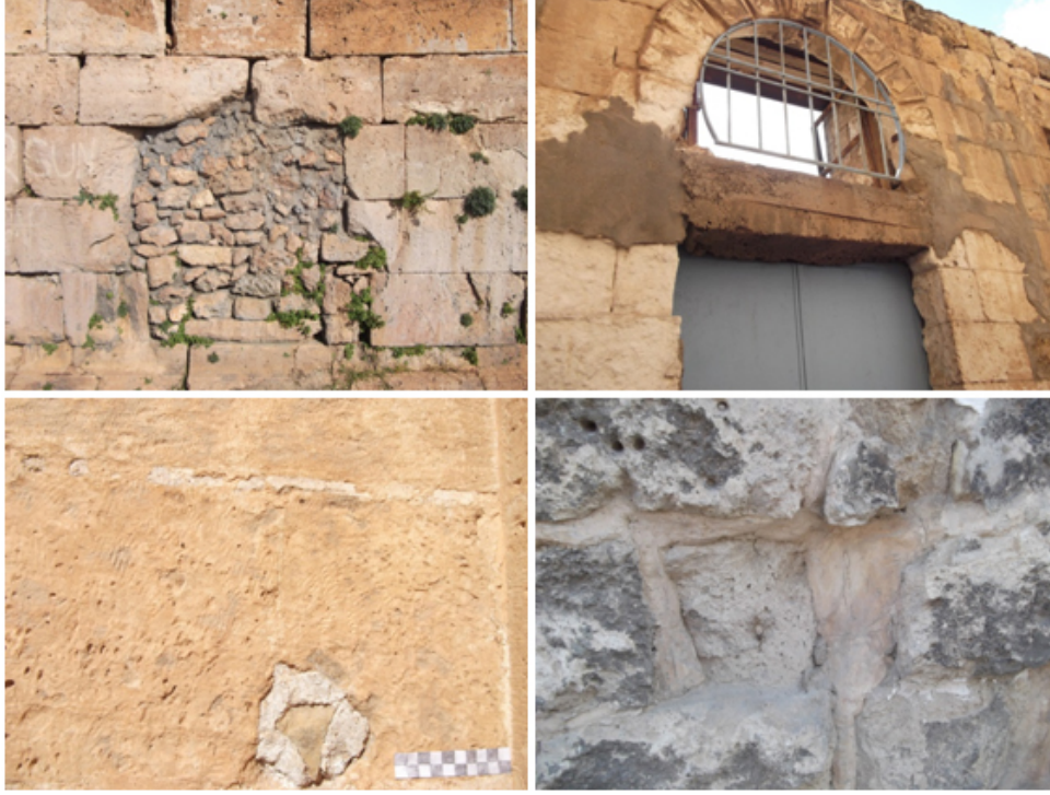
Şekil 11. Restorasyon amacıyla taşın çatlamasından sonra kırılarak ayrılmasının engellenmesi için çatlak bölümün çimento ile doldurularak onarılması.
