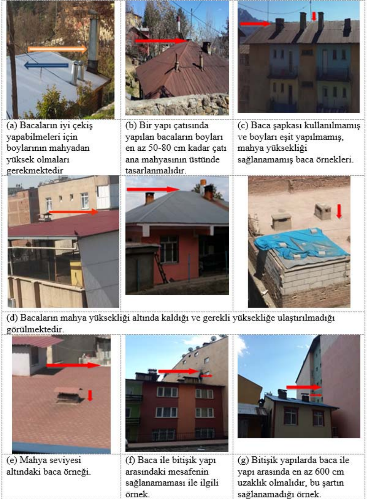
Şekil 20. Standartlara uygun olmayan baca örnekleri
