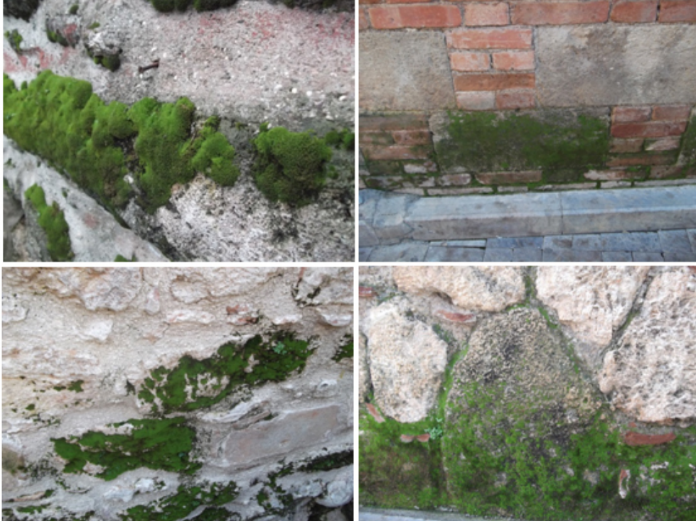
Şekil 10. Mardin'deki özellikle şehir içindeki yapılarda gözlenen yosunlaşmanın 1-2 milimetre arasında değiştiği gözlenmiştir. Yosunlar, ayrıca salgıladığı asidik enzimlerle taşı ayrıştırarak taş yüzeyi ile kendi gövdesi arasında ince bir toprak tabakası oluşturmaktadır.
