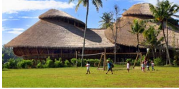
Şekil 17. Bali Yeşil Eğitim Merkezinde Ana Binanın Dışındaki Yeşil Alan (URL-9)
