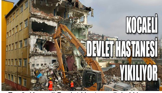
Fot.2: Kocaeli Devlet Hastanesi'nin Yıkımı (Özgür Kocaeli Gazetesi, 19 Aralık 2014)
