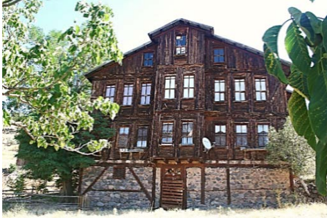
Resim 5. Kozyaka Köyü/ Abdullah Demirel Evi Zemin (Ahır) + 2 Kat +Tavan Arası Bulunan Konak Örneği
