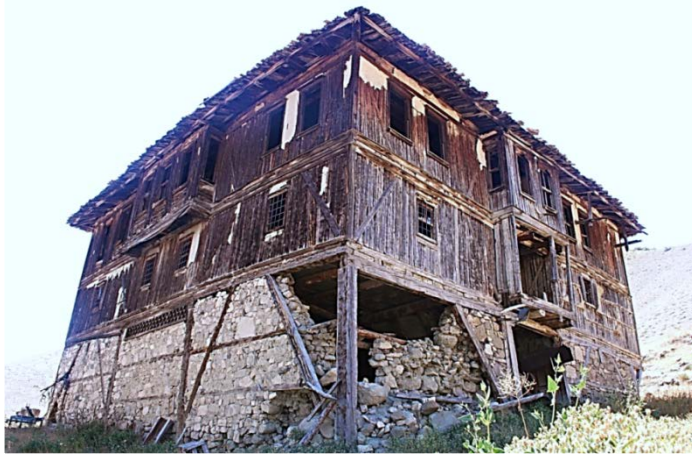
Resim 40. Nimetli Köyü/ Fevzi Yerlikaya Evi/ geleneksel konut mimarisinde ahşap ve taş kullanımı
