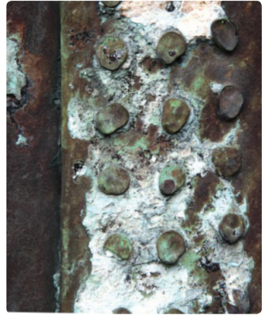
Resim 15. Kastamonu Vakıf Hamamı külhan kazanı perçin ayrıntısı (kazan tabanı iç yüz).
