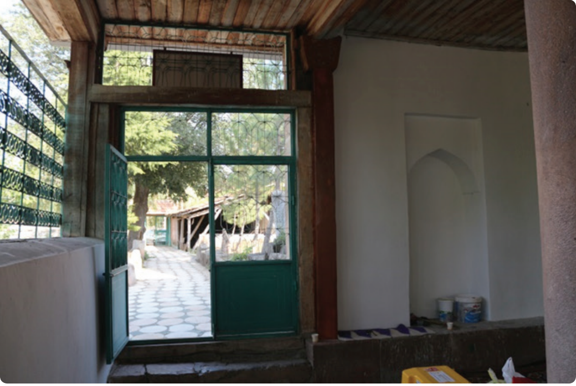
Resim 3. Yapiya Giriş ve Avlu Doğu Duvarı
