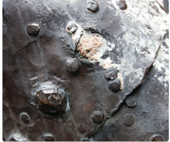
Resim 43. Tasya Tekke Hamamı külhan kazanı dış yüzünden çivi perçin ayrıntısı (üstte).
