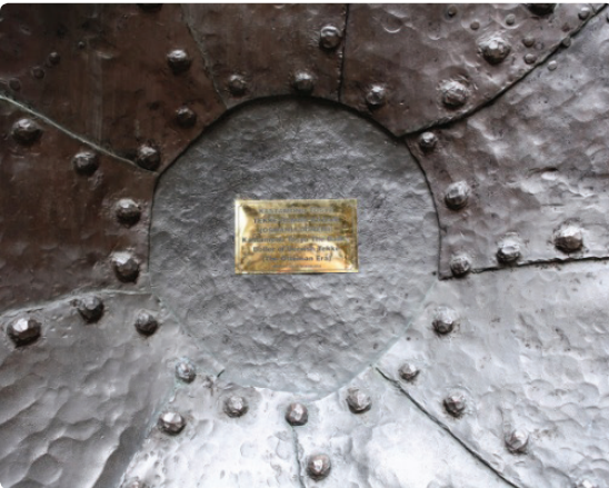
Resim 38. Tosya Tekke Hamamı külhan kazanı dış yüzü taban levhası ve çevresi.
