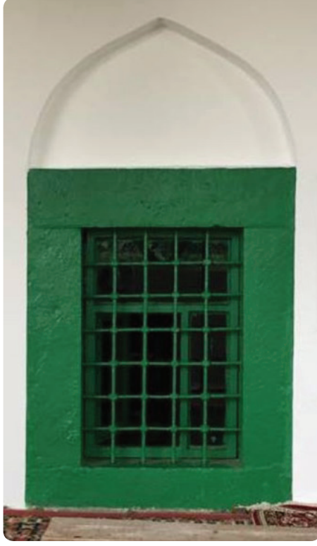
Resim 5. Avlu Güney Duvarında Bulunan Türbe Penceresi
