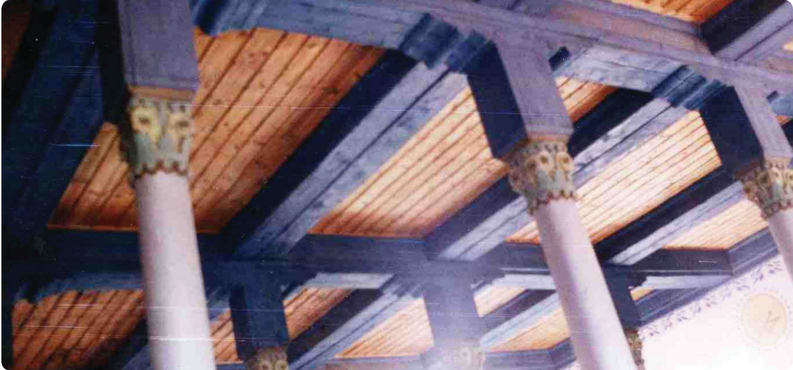
Resim 4. Kale Cevher Paşa Câmi Ahşap Kirişler ve Profilli Yastıklar (VGMA,20: 2006).
