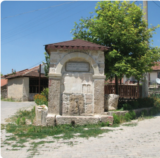
Resim 8. Avgan Köyü, Acı Kuyu Çeşmesi.
