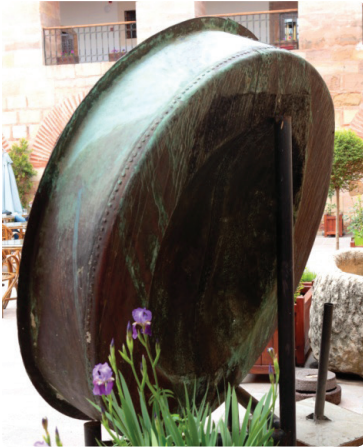
Resim 13. Kastamonu Vakıf Hamamı külhan kazanı dış yüzü (ateşe temas eden kesim).
