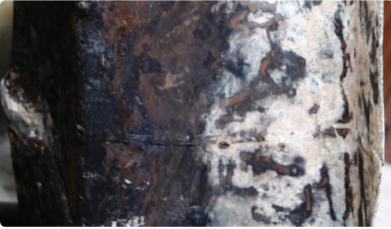
Resim 28. Kastamonu Dede Sultan Hamamı külhan kazanı dış yüzünden ayrıntı; kasnakta dişler ve kaynak.
