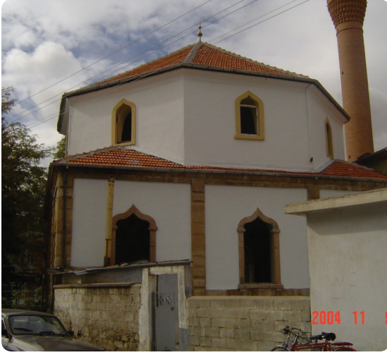
Resim 43. Çivril Çarşı Câmî onarım sonrası (VGMA, 20: 2004).
