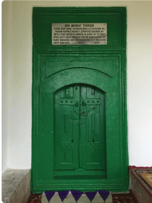
Resim 4. Avlu Güney Duvarında Bulunan Türbe Kapısı
