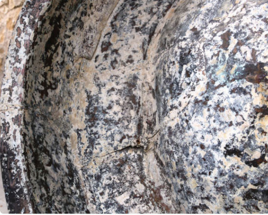
Resim 21. Kastamonu Dede Sultan Hamamı külhan kazanı iç yüz ayrıntısı (altta); tamir (yama) levhasının bulunduğu kesim ve yakın çevresi.
