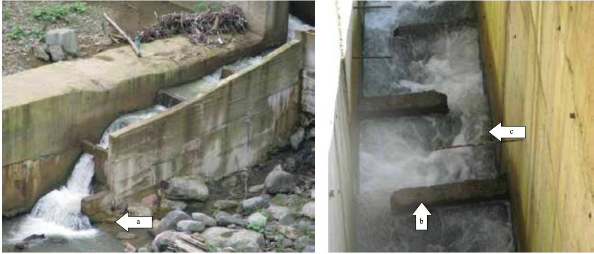
Şekil 7. a-c. Araştırma bölgesinde yaygın olarak uygulanan ‘havuzlu balık geçidi’ne ilişkin yapısal detaylar: (a) Mansapta balıkların geçide ilk giriş yaptığı, en düşük kottaki nokta. (b) Havuzu balık geçidi, (c) Balık geçidi perdeleri.
