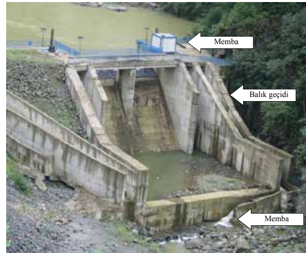
Şekil 6. Trabzon, Sürmene, Köprübaşı Manahoz Deresi üzerinde 2009 yılında işletmeye açılan bir regülatör üzerinde 90° açıyla inşa edilen bir balık geçidinin genel görünüşü.
