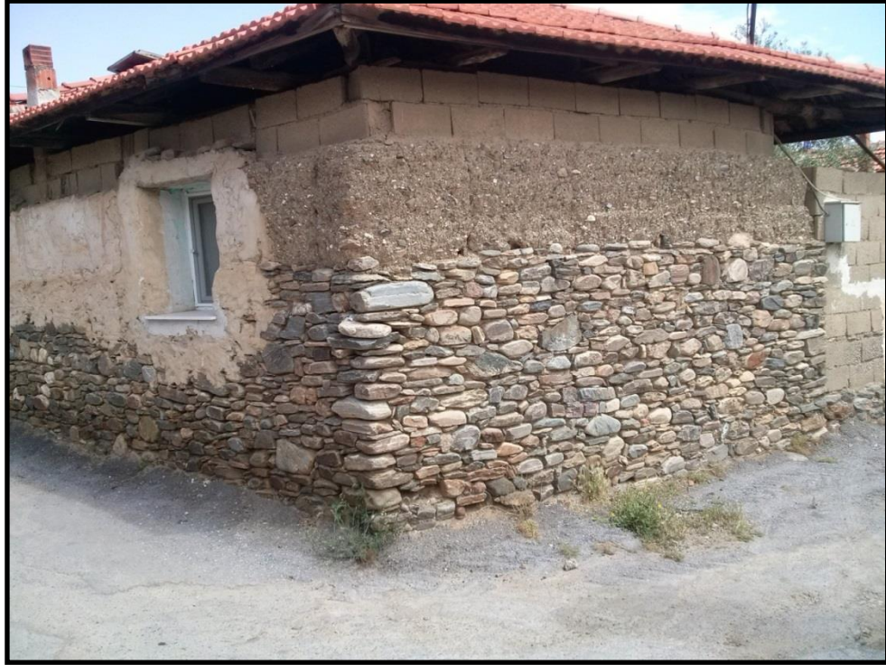
Fotoğraf 3: Çıkrıkçı Köyünde Altta Taş Temel ve Taş Duvar Üzerinde “Depme Duvar” İnşa Edilmiş Bir Meskenin Duvarı
