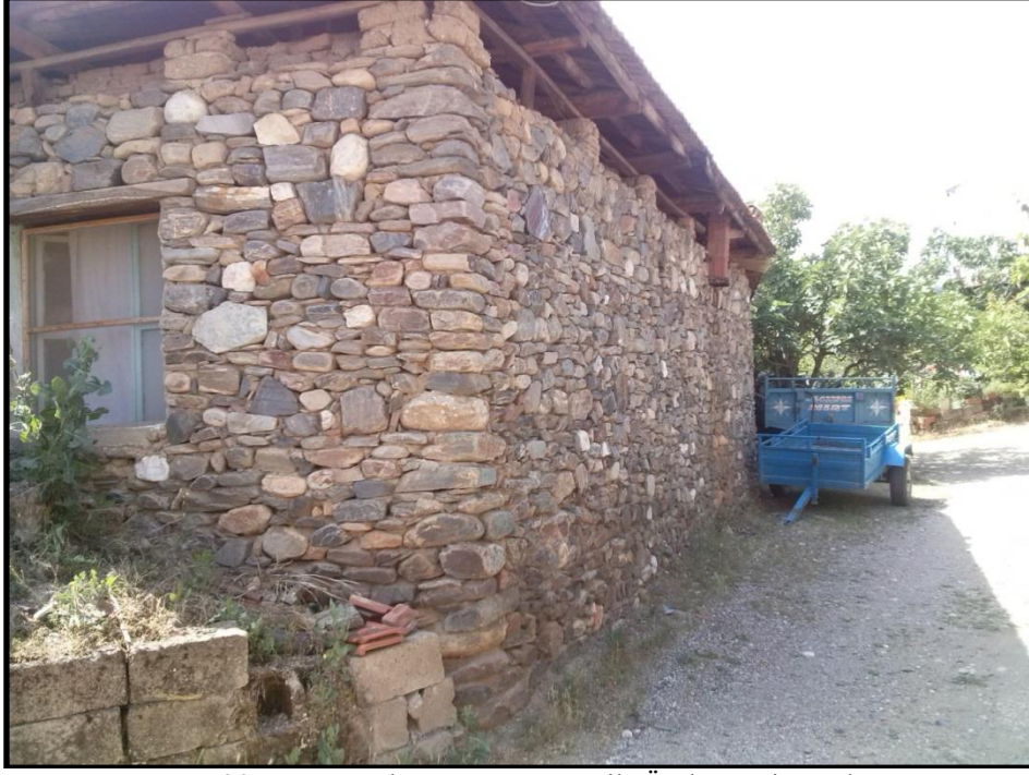
Fotoğraf 2: Dış Duvarları Tamamen Taş ile Örülmüş Bir Mesken
