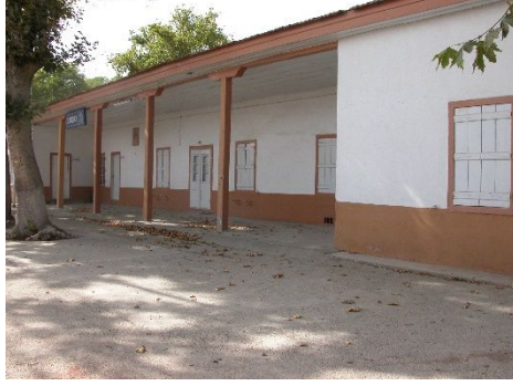
Resim 12: Denizli/Çardak Tren İstasyonu Binası (Bekleme Salonunun Doğusundaki Oda)
