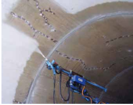
Şekil 2. Su yalıtım amaçlı bir PİK uygulaması (Wallis, 2008)
