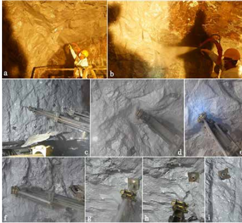
Şekil 13. PİK püskürtme işlemi (a ve b), PİK kaplanmış galeride saplama delgisi (c ve d), Split set türü sürtümlü saplamaların delik içerisine çakılması (e, f, g, h ve i)
