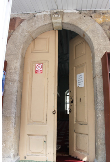
Foto. 25: Tıflı Camii, batı kapısı.
