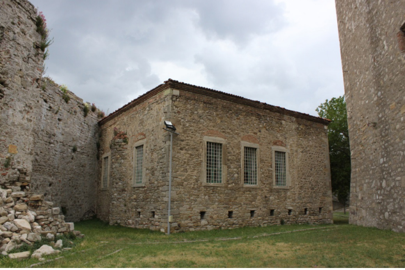
Foto. 14: Abdülaziz Mescidi, güneydoğudan görünüm.
