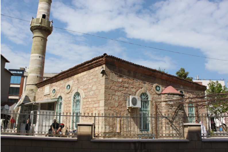
Foto. 23: Tıflı Camii, güneybatıdan görünüm.
