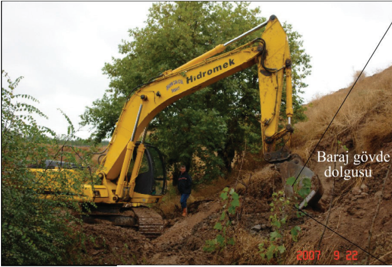
Şekil 4. Baraj gövde dolgusu ile kahverengi kil arasındaki alüvyonda su kaçağı.
