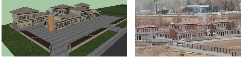
Şekil 15. Erzurum Sokağı'nın Yola Bakan Kısımında Tepsi Minare Tarafından Alana Bakış (a) Tasarım Aşaması (b) Sahada Uygulanmış Hali
