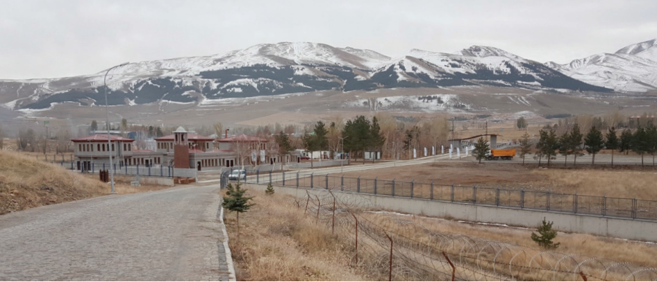
Şekil 9. İlk Etapın Uygulaması
