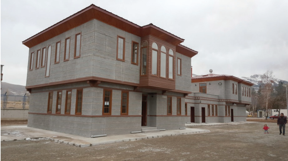
Şekil 16. Erzurum Konağının Giriş ve Yan Cephesi
