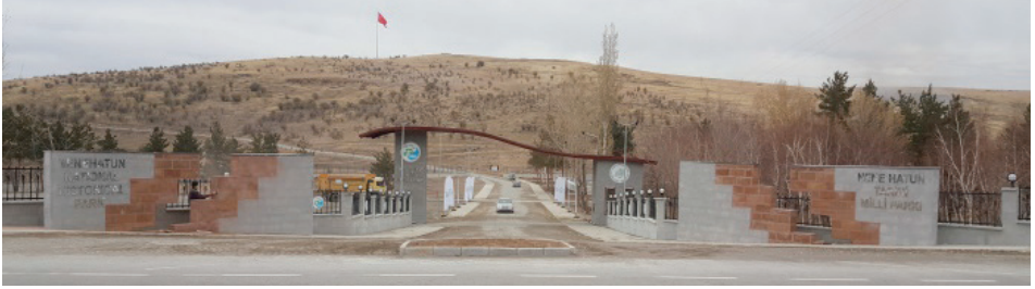
Şekil 11. Giriş Kontrol Ünitesinin Sahada Uygulanmış Hali
