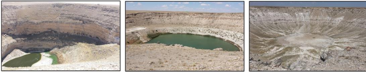
(a) Çıralı Sinkhole
