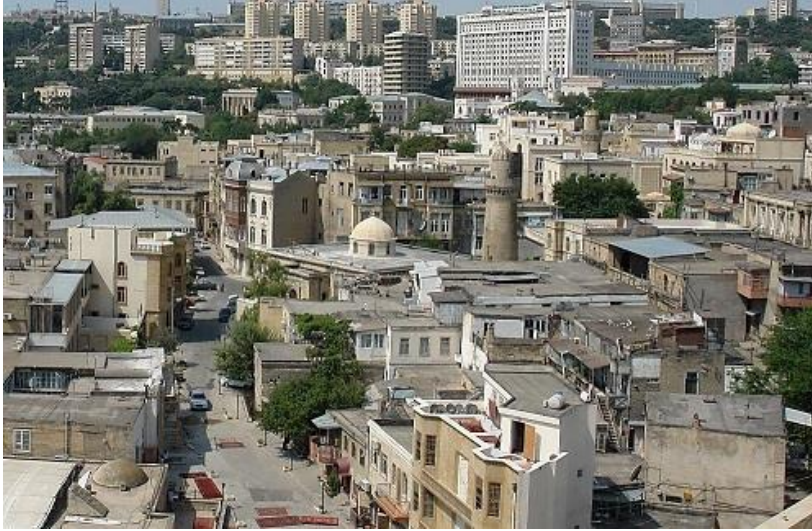
Resim 5. Bakü Cuma Camii. Kuzeydoğudan genel görünüşü
