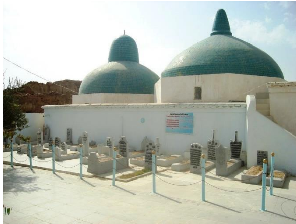
Osmanlı Subay Mezarlığı (Restorasyon Sonrası)
