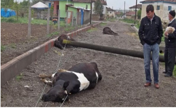
Şekil 5. Düzensiz havai elektrik hatları
