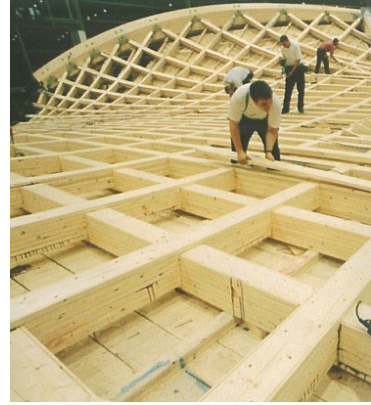
Şekil 4. Fuar alanı inşaatı
