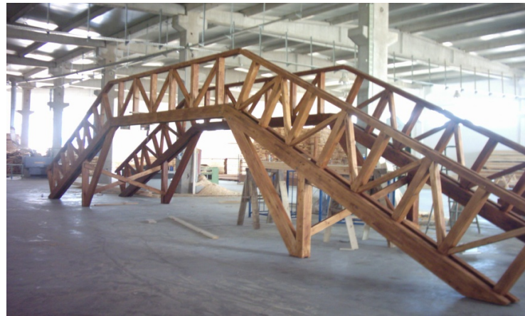
Şekil 8. Köprünün tamamlanmış hali
