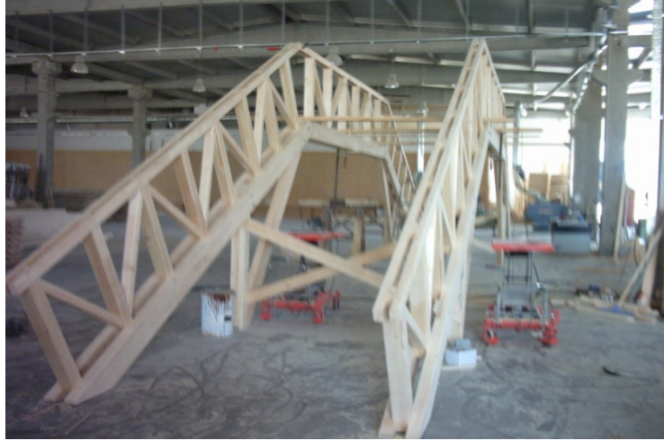
Şekil 7. Köprünün yapılış aşamasında
