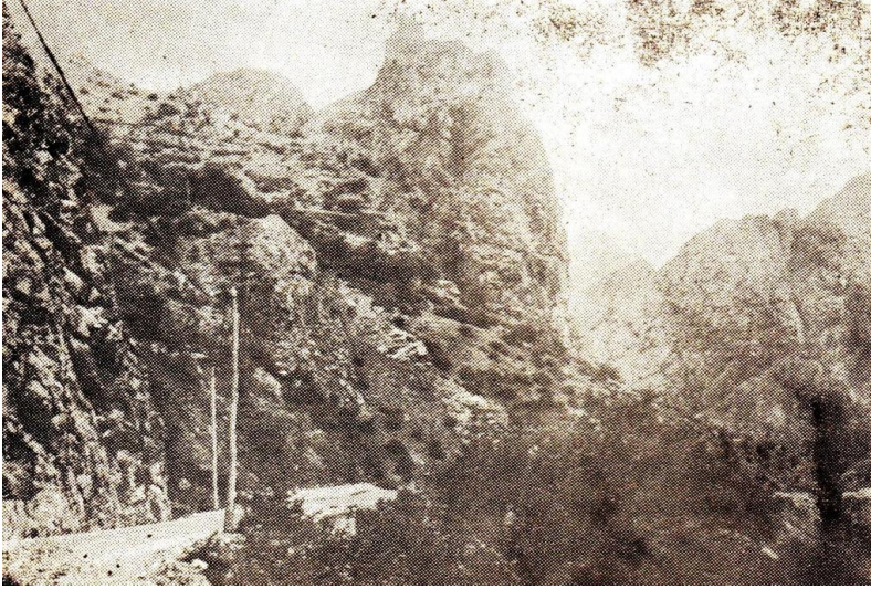
Artvin Kalesi hem yapılan yeni yola hem de karşıya geçiş için yapılan köprüye hâkim bir konumdadır.
