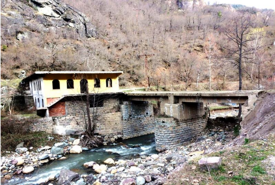
Hacipaşa Köprüsü'nün kuzeyden görünümü ve yapılan restoran.
