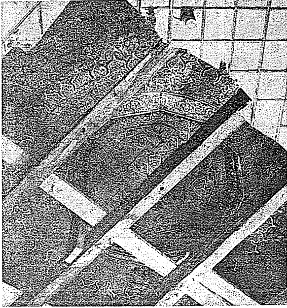
Resim 12 b. Kubbeyi yırtan muhdes düz tavanlı çıtalı tavan kirişlemesi.
