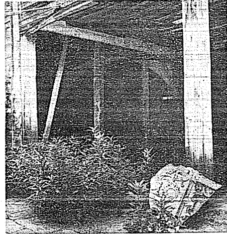
Resim 3. Arabalık. Tavan çökme tehlikesi gösterdiği için ilâve direklerle desteklenmiştir. Önde, Alt kat sofaya ait çeşmenin ayna taşının kırık bir kısmı görülmektedir, üzerinde evin inşa tarihini gösteren 1750 tarihi vardır.
