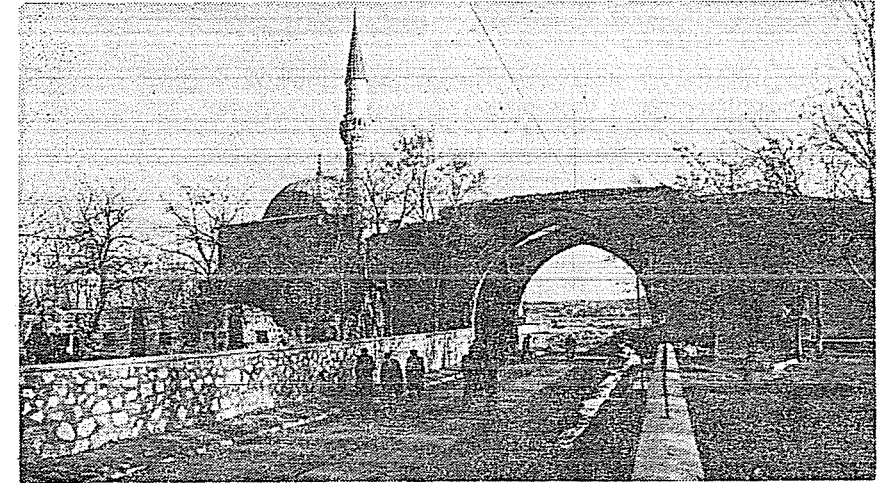
Resim 2. Arasta, duâ kubbesi, cami ve ocaklı duvar, hamam tarafından
