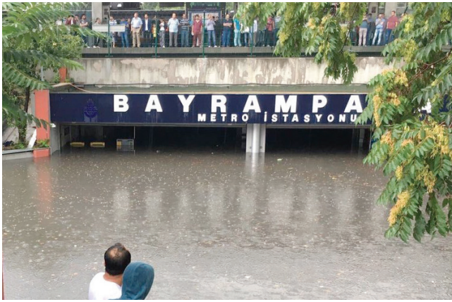
Şekil 2. 18 Temmuz 2017 tarihinde meydana gelen şiddetli yağış sonucu Bayrampaşa Metro İstasyonu'nun sular altında kalması
