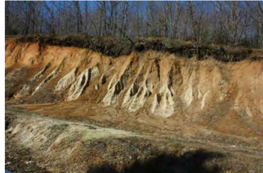
Fotoğraf 1. Bahçedağ güneyinde yapılan stabilize yol çalışmasıyla yamaç gradyanı bozulmuş, arazi örtüsünün ortadan kaldırıldığı sahalarda kırılgan ve alüvyal fanlar meydana gelmiştir (16.02.2017).
