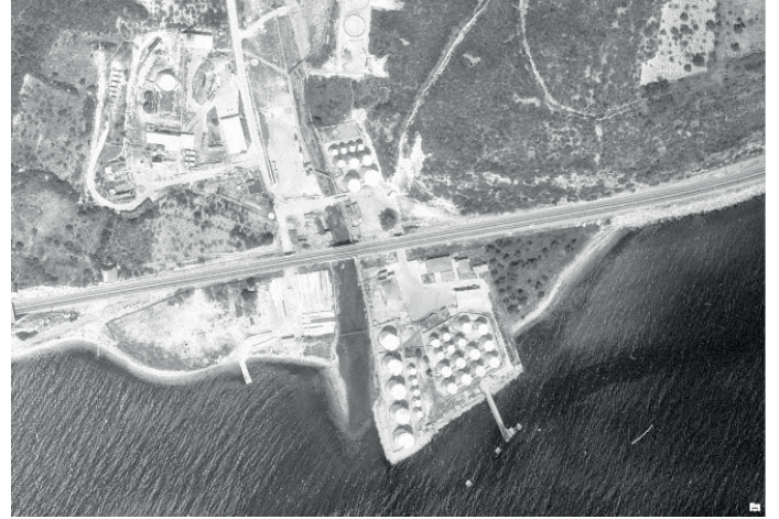
Foto 15: 1976 tarihli hava fotosunda Narca Dere ve değiştirilmiş ağızı, yamaç hafriyatı ve tünel kazısından çıkan malzemeler ile oluşturulan dar-yüksek yapay kıyı.
