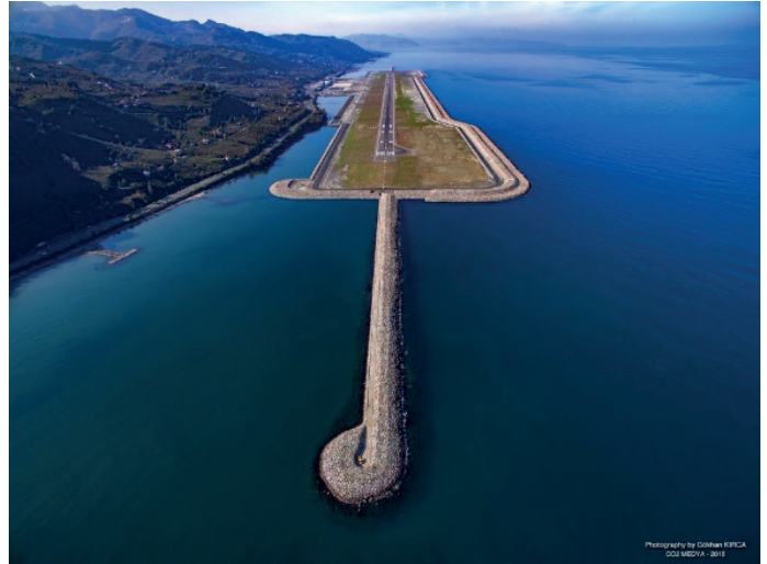
Foto 4: Ordu-Giresun Havaalanı dolgu alanı ve “Dar-Yüksek kıyı” tipindeki yapay kıyı.
