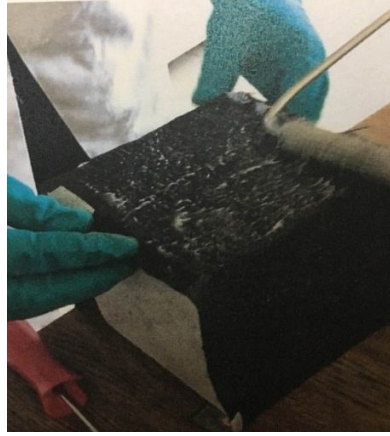
Şekil 1: Karbon kumaşın beton üzerine uygulanması
