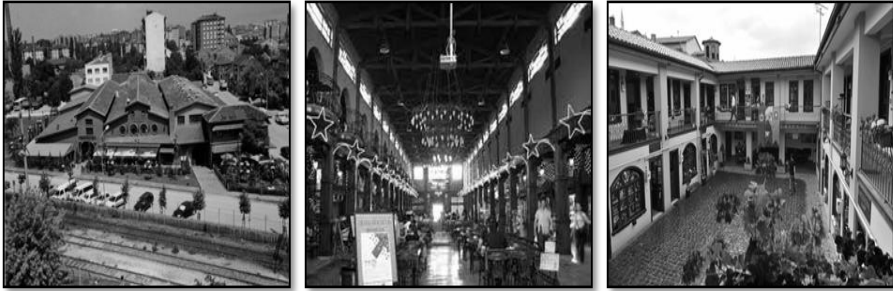
Fotoğraf 4: Büyükşehir Belediyesi'nce Gençlik Merkezine Dönüştürülen Hal Binası ve Odunpazarı Belediyesi'nce restore edilen Atlıhan Çarşısı ( http://Odunpazarihouses.com/wp , 2012 )
