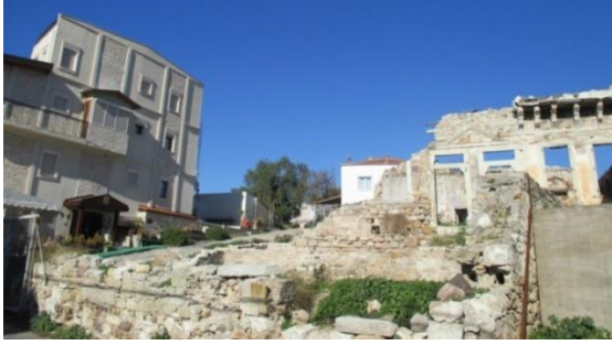
Şekil 7. Ağalar Konağı ve yapının kalıntıları üzerine yapılan otel (Taşcı, 2015)
