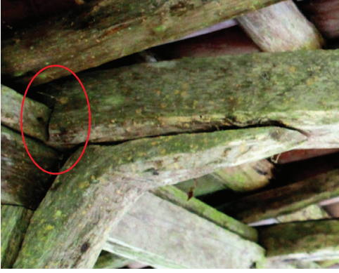
Fot. 23: Kiremitli Köprü; Gergi - Çatı Kirişi Arasında Kanallı Geçme.
