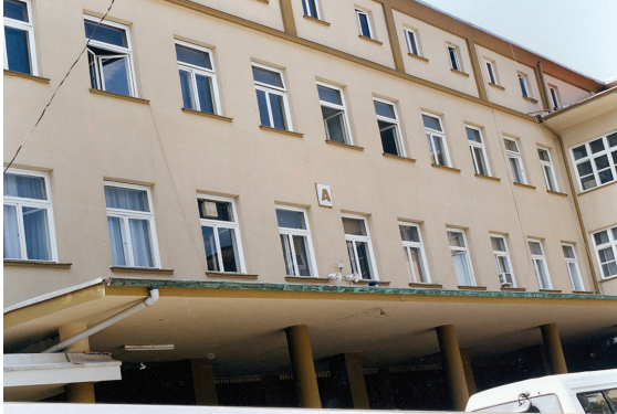
Res. 16: A Blok giriş saçağı.
