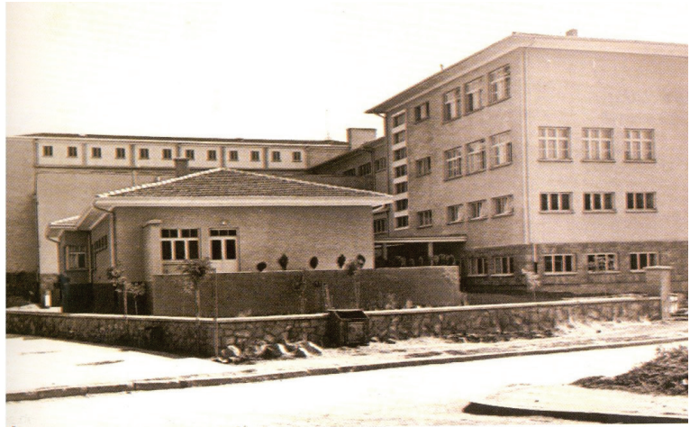
Res. 18: A Blok ve Müdür Lojmanı Batı Cephe. (ALEV Arşivi.)
