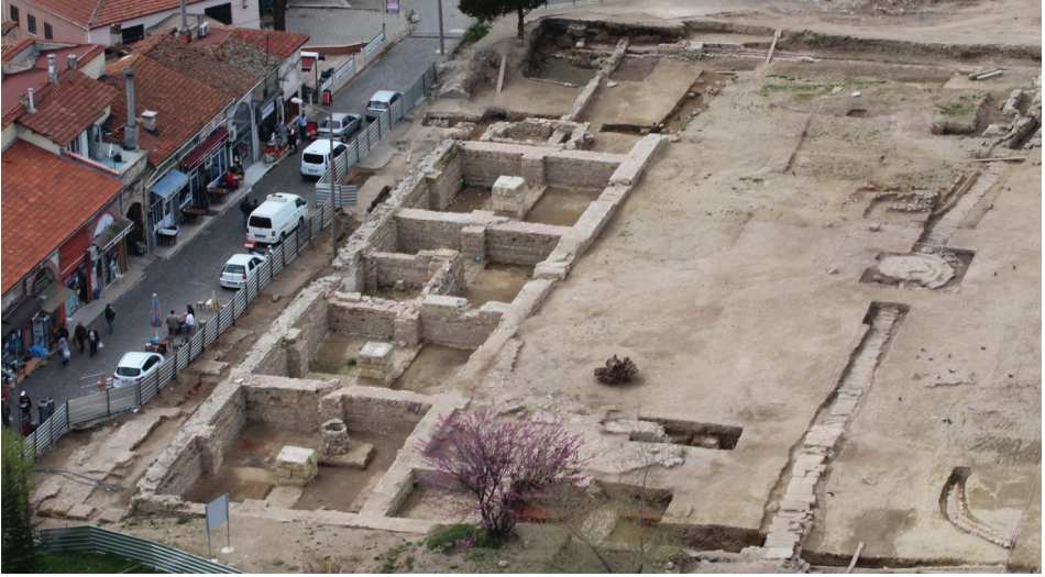
Fot. 2: Edirne, Yemiř Kapanı kazı sahası, güney cephedekinin dođu ucundaki depo mekanları. (Yemiř Kapanı Hanı'nın Rölöve Raporu'ndan.)
