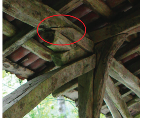
Fot. 24: Kiremitli Köprü; Çatı Kirişlerinde Pahlı (Şevli) Boy Birleşme Ayrıntısı. (Mansab)
