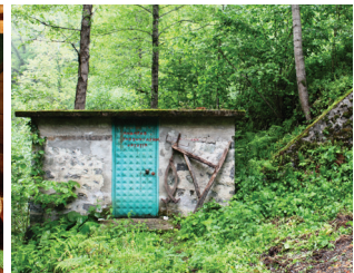
Fot. 10: Köprü'nün mansab tarafında, betonarme olarak yenilenmiş değirmen. (Çiz.1'de 6)
