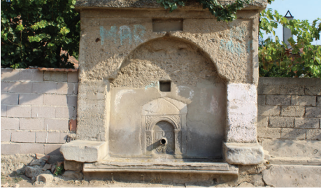
Fot. 1: Çevre Köy Türkmenler Çeşmesi.
