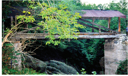
Fot. 39: Ordu - Perşembe, Hacılar köyü Ahşap Köprü. (Şerife Tali'den)
