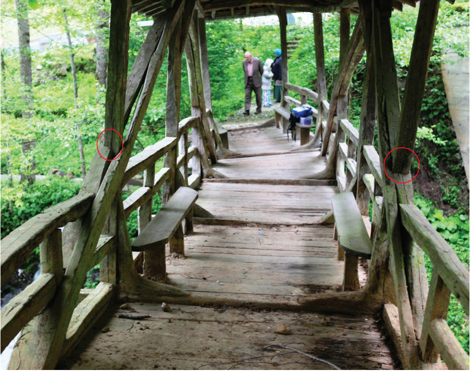
Fot. 20: Kiremitli Köprü; Batı Yönden Tabliye Detayları. (İşaretli kesimlerde: Payanda - Direk arası kanallı geçmeler.)
