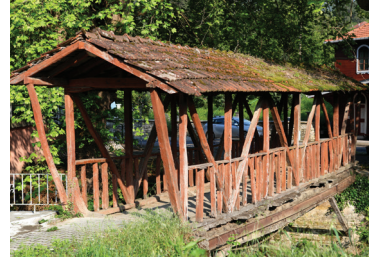
Fot. 41: Kastamonu - Bozkurt İlişi Cumayanı Köprüsü.
