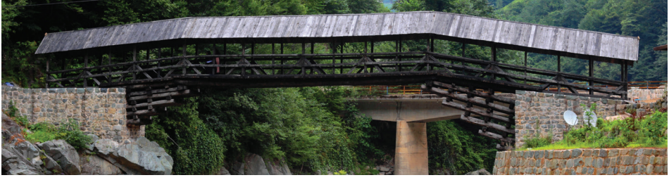
Fot. 33: Rize - Çayeli - Buzlupınar Köyü Köprüsü.
