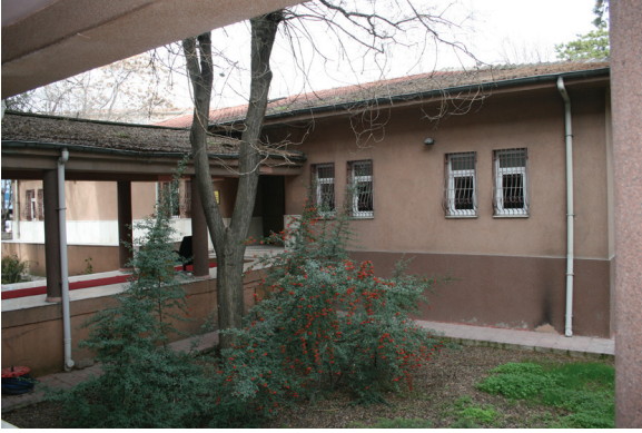
Res. 11: Müdür Lojmanı ile A Blok arasındaki saçak.
