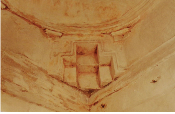
Res. 3: Alaşehir (Sülün Muslu Paşa) Hamamı. Erkekler bölümü aralık mekânında kubbe geçiş unsuru.
