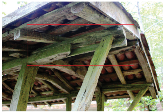
Fot. 27: Kiremitli Köprü; Batı Girişte Çatı Ayrıntısı. (İşaretli kesim: Çatı kirişine sonradan yapılan ilave.)
