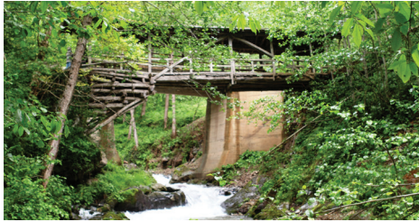
Fot. 4: Kiremitli Köprü. Kuzeydoğu/mansab yüzü.
