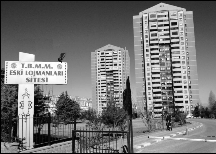
Milletvekilleri Sitesi yapı grubundan geriye kalan yüksek katlı bloklar
