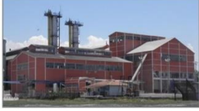
Foto 7. Küşpe Kurutma Binası
