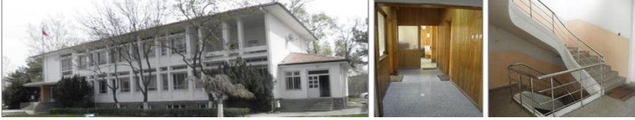
Foto 4. Şeker Fabrikası Yönetim Binası Doğu ve Kuzey Görünüşü, Giriş Holü ve Merdiveni
