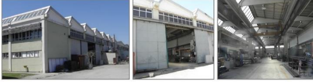
Foto 16. EMAF Ana Binası, Ön Cephesi ve İç Mekanı
