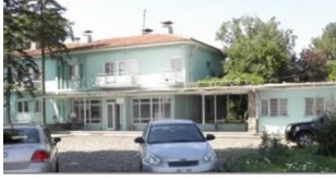
Foto 18. Ofis ve Lojman Binası
