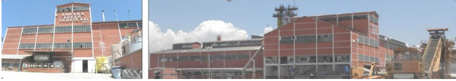
Foto 1. Şeker Fabrikası Ana Bina'nın ön ve yan cephesi
