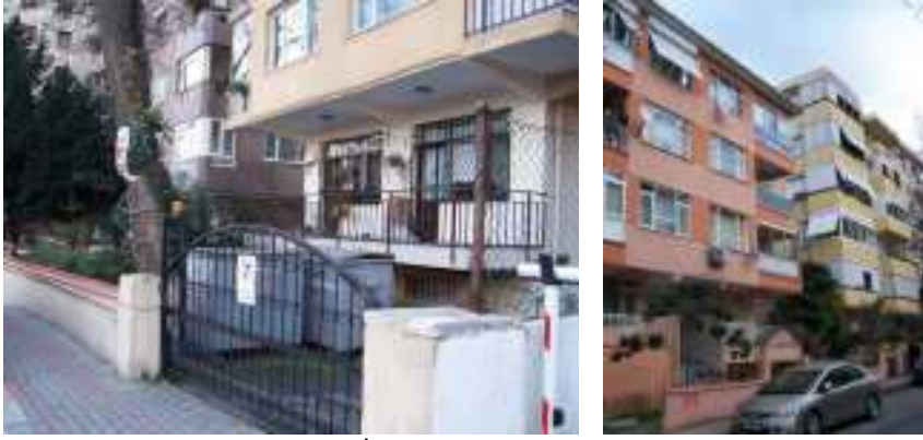
Şekil 13. İkinci Dönem Apartmanları Kaynak: Arıkan, 2012
