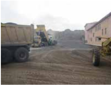
Alt yapı çalışmaları
