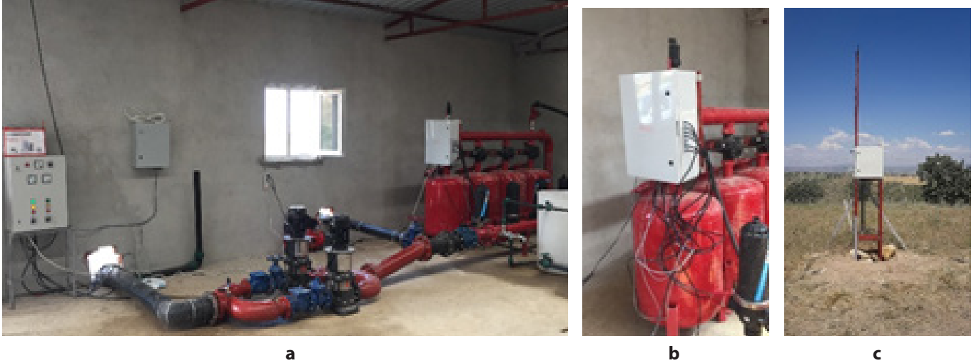
Figure 3. Filtration unit (a), FCN (b) and coordinator & modem point (c). Şekil 3. Filtrasyon ünitesi (a), FCN (b) ve koordinatör ile modem noktası (c).
