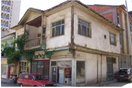
Şekil 19: Elif Demirçal Evi (Fot:U.Demirbağ)
