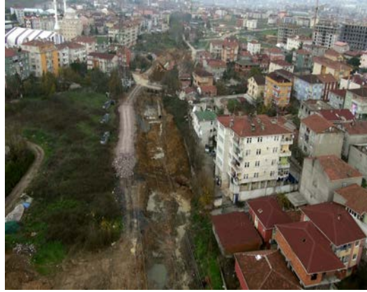
Şekil 4. Ayazma deresi ıslah çalışmaları, Sancaktepe.
