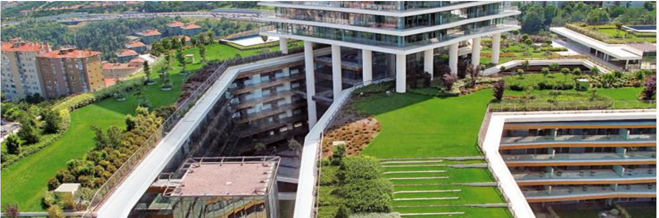
Resim 5. Yoğun (İntensif) Bitkilendirilmiş Yeşil Çatı Örneği (HDB Car Park Roof)
