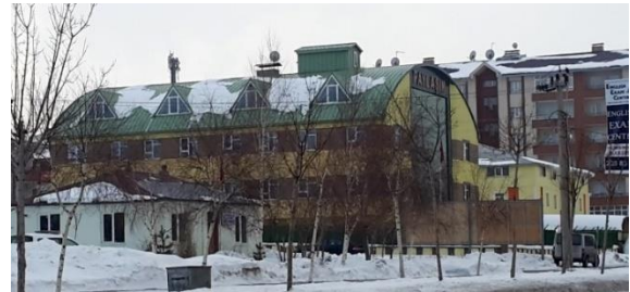
Resim 1-3. Çatı formu ve malzemesi çatıdaki karın tahliyesini birinci derecede etkilemektedir
