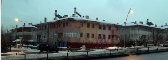
Resim 7-8. Çatıdaki engeller karın tahliyesini engellerken, ısı kaçakları buz sarkıtlarının oluşumuna sebep olmaktadır.
