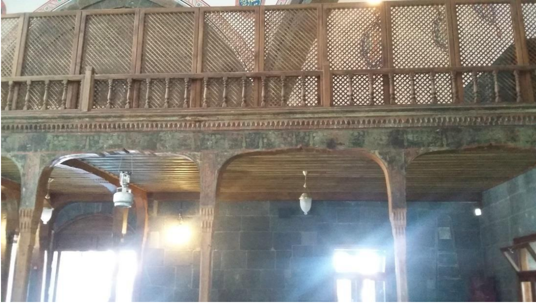
G.5 - Narmanlı Camii ahşap kadınlar mahfili restorasyon sonrası görünümü. (Selma Gül)
