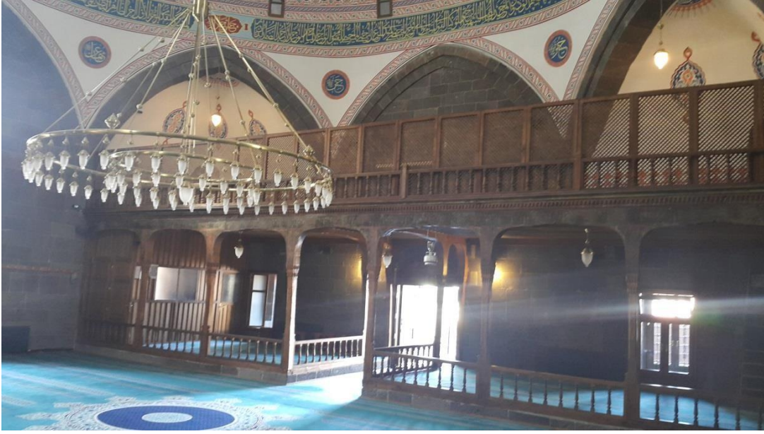
G.4 - Narmanlı Camii ahşap kadınlar mahfilinin restorasyon sonrası yağlı boya raspa yapılarak ortaya çıkarılan özgün görünümü. (Selma Gül)
