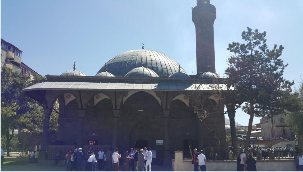
G.2- Narmanlı Camii giriş cephesi (Selma Gül)
