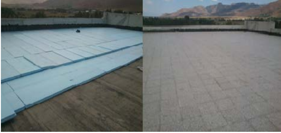
Fot.1: Teras çatı izolasyonu ve suni mermer karo ile kaplanması (Prokon&Beşer Ortaklığı, 2012).
