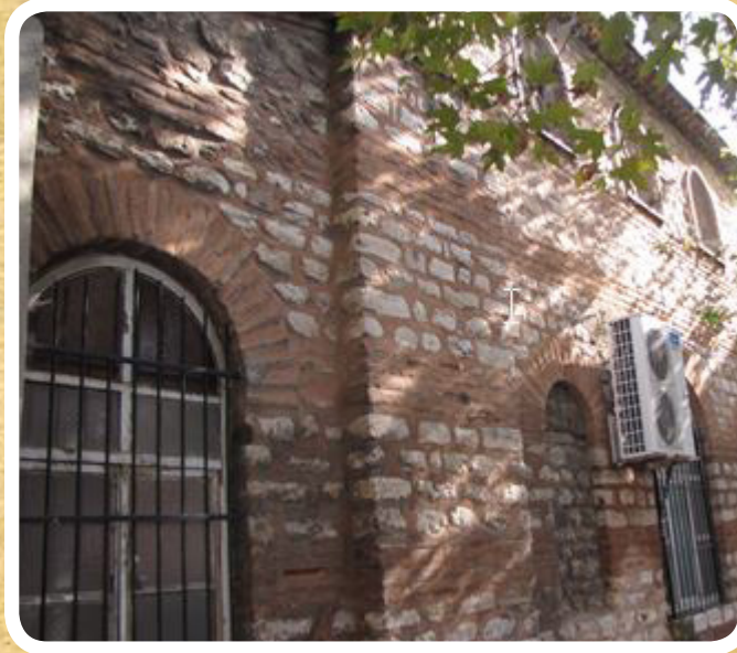
Resim 5. Güney cephe, tuğla ve kesme taş sıralı duvar örgüsü ve yuvarlak tuğla kemerli pencereler, (Fotoğraf: L.Y.)
